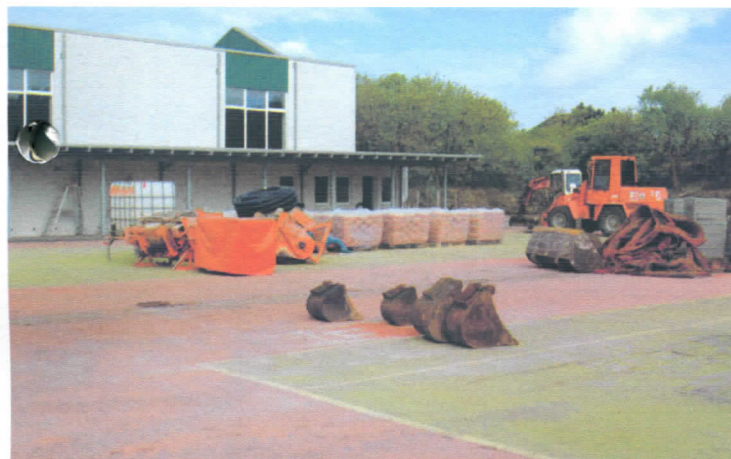
Mit kleinem Bagger und Radlader wird auf der Anlage gewerkelt.
